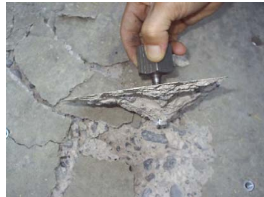
Figura B.5 fractura del hormigón donde se utilizaron los tacos de expansión
