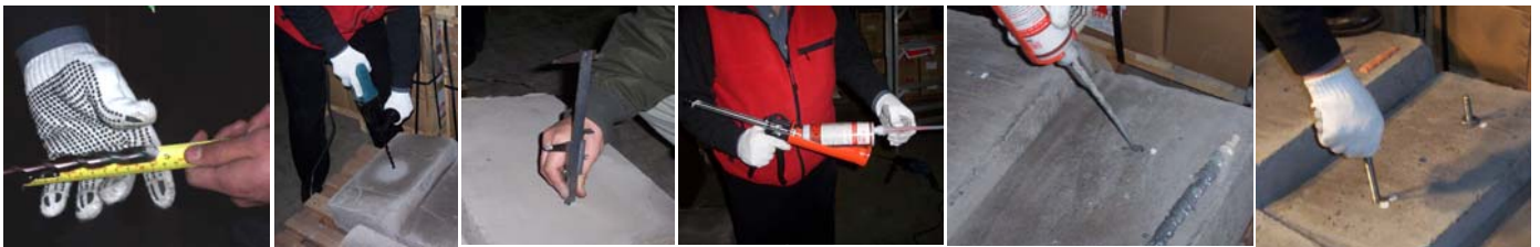
Figura A.1 Proceso de instalación de las varillas químicas.
